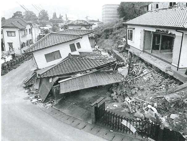
熊本地震被災地 8月1日リボンガス撮影
