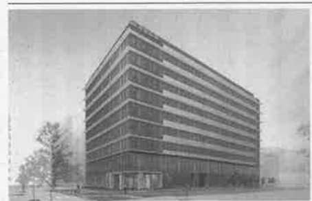
福岡酸素(本社・久留米市、福田寛一社長)は9階建て、総賃貸面積約1万5345平方メートルのオフィスビルを建設する。完成は2021年6月の予定。敷地面積は約3610平方メートル、延べ床面積は約2万1499平方メートル。鉄骨構造で制震性の高い工法を採り入れた。BCP対策として2系統から電力を供給する
